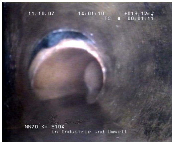
Bild 1: Klaffende Rohrverbindung
