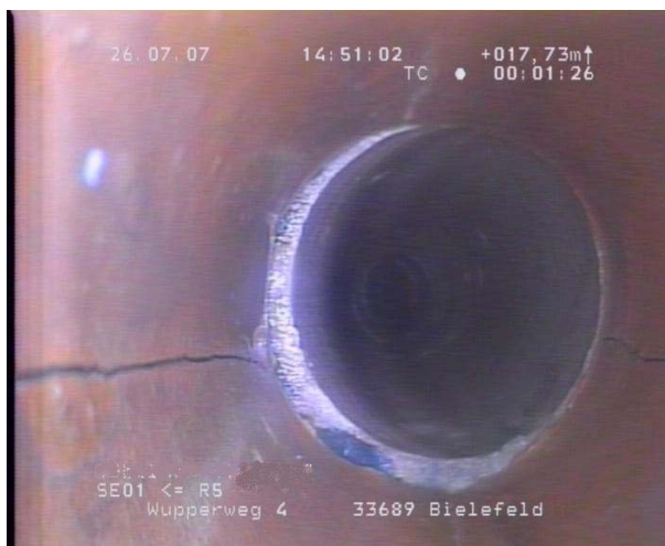
Bild 3: Längsriss
