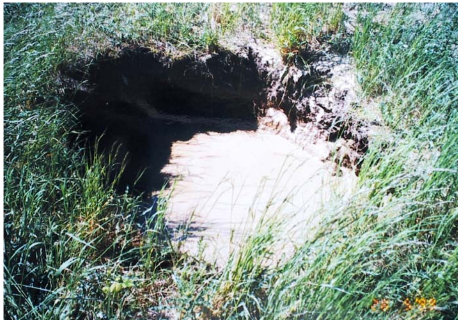
3 Ein weiteres typisches Schadensbild: der Grundbruch (Fotos GSTT)
