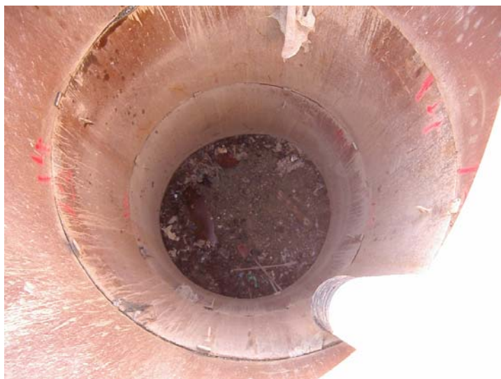
Austausch eines Rohrkurzstückes im Schutze eines Stahlrohverbandes
