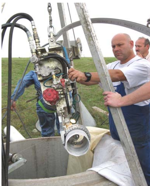
Renovierung einer Entwässerungsleitungen mit Ribloc-Wickelrohr
