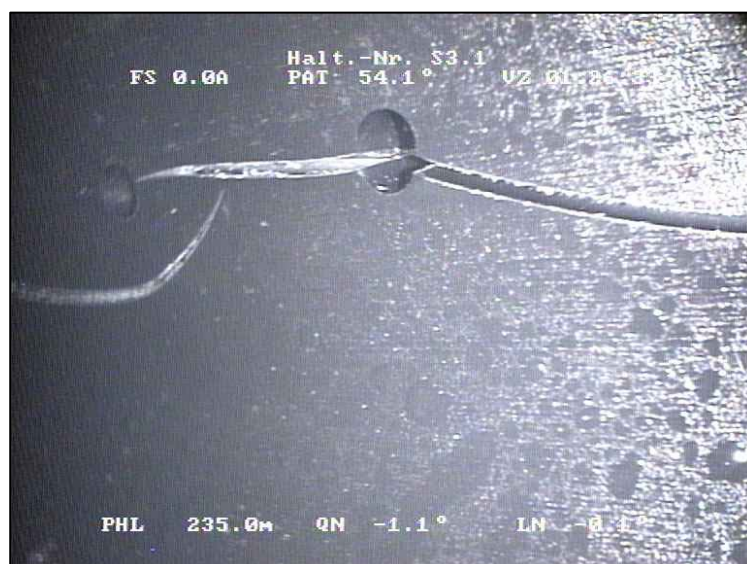
Typischer Längsriss beginnend an einem Loch
