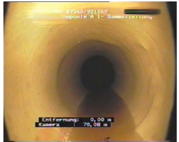
Sanierter Einsturz bei ca. 70 m
