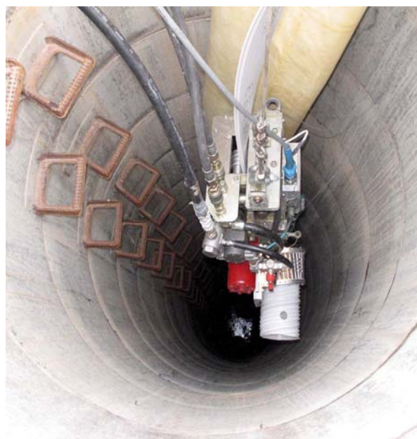
Renovierung einer Entwässerungsleitungen mit Ribloc-Wickelrohr
