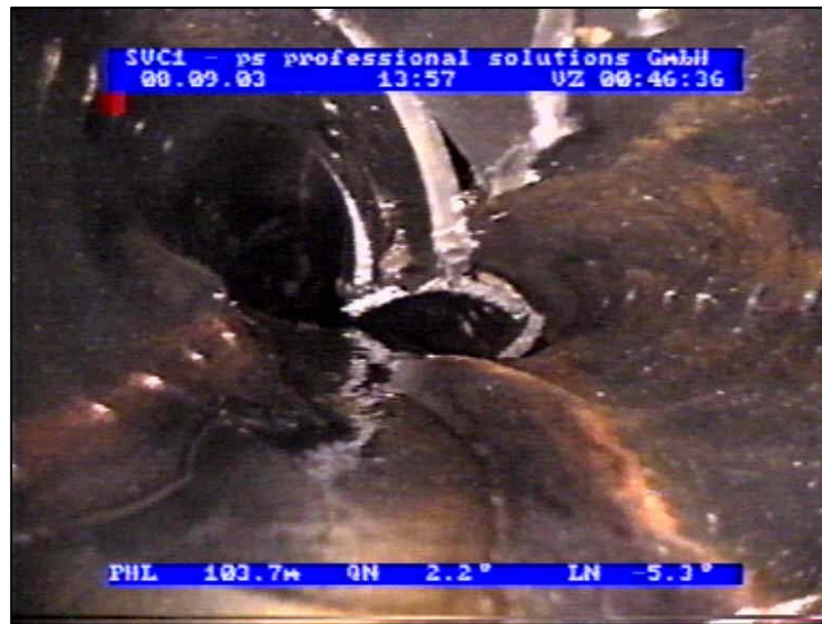
Einsturz einer gelochten PE-Sickerwasserrohr
