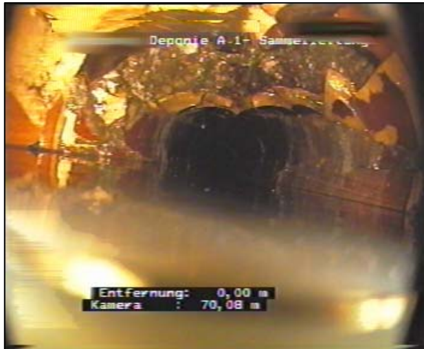
Offener Rohrscheitel bei 70 m
