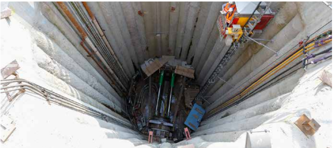
Baugrube mit Bohrpfahlsicherung
