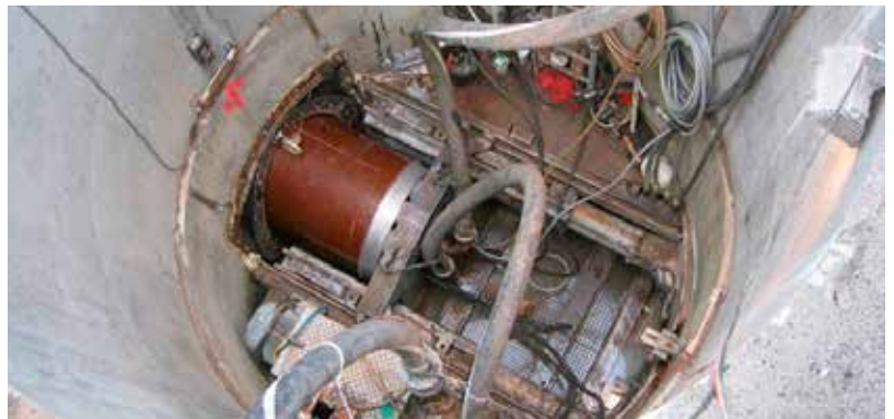
Stahlbetonabsenkschacht mit Unterteil und Aufsatzteil
