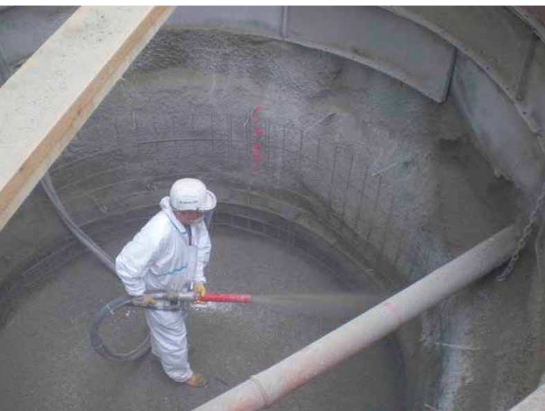
Spritzbetoneinbau
