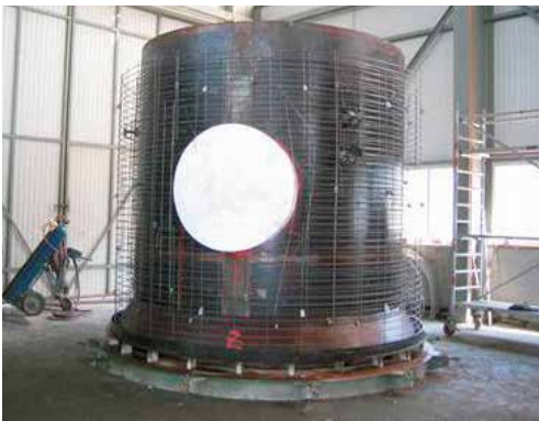
Unterteil Absenkschacht mit Bewehrung und Durchfahrtsöffnung
