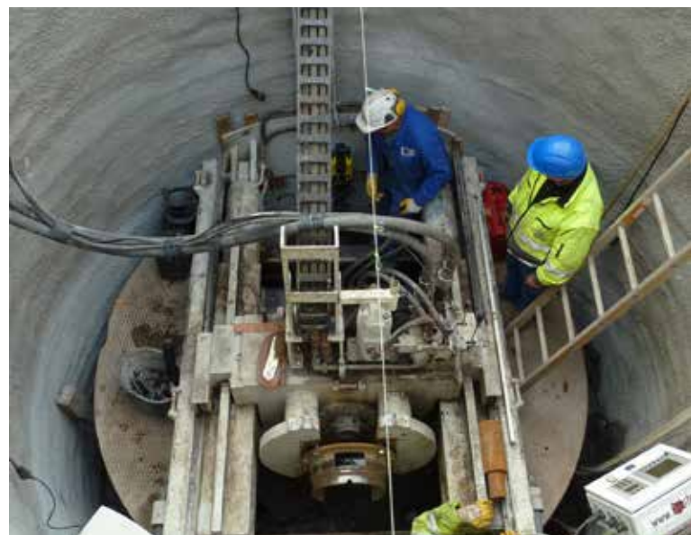
Baugrube mit Spritzbetonsicherung
