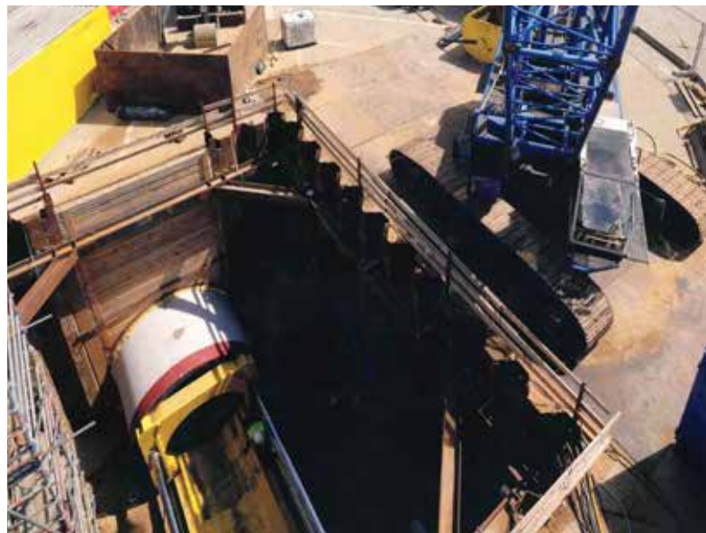
Kombinierte Baugrube aus Spundwand und Trägerbohlwand
