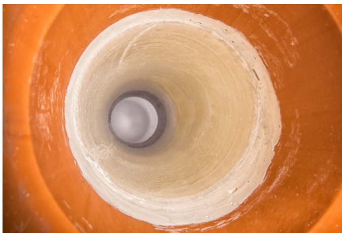
Bild 6: In PVC-Rohr eingebauter Kurzliner
