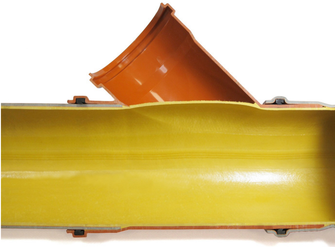
Bild 3: Ausgehärteter Schlauchliner in einem PVC-Rohr
