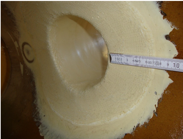
Bild 7: Eingebautes Anschlusspassstück (Hutprofil)
