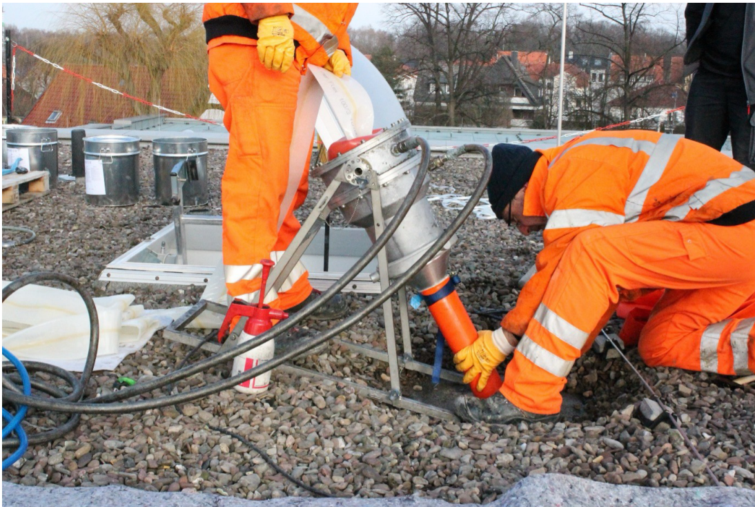
Bild 2: Einbau eines Schlauchliners in die Entlüftungsleitung eines Flachdachs (Quelle: MaxLiner)
