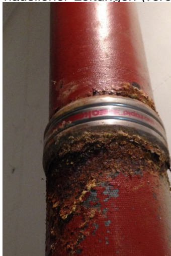
Bild 9: Undichte Manschettenverbindung
