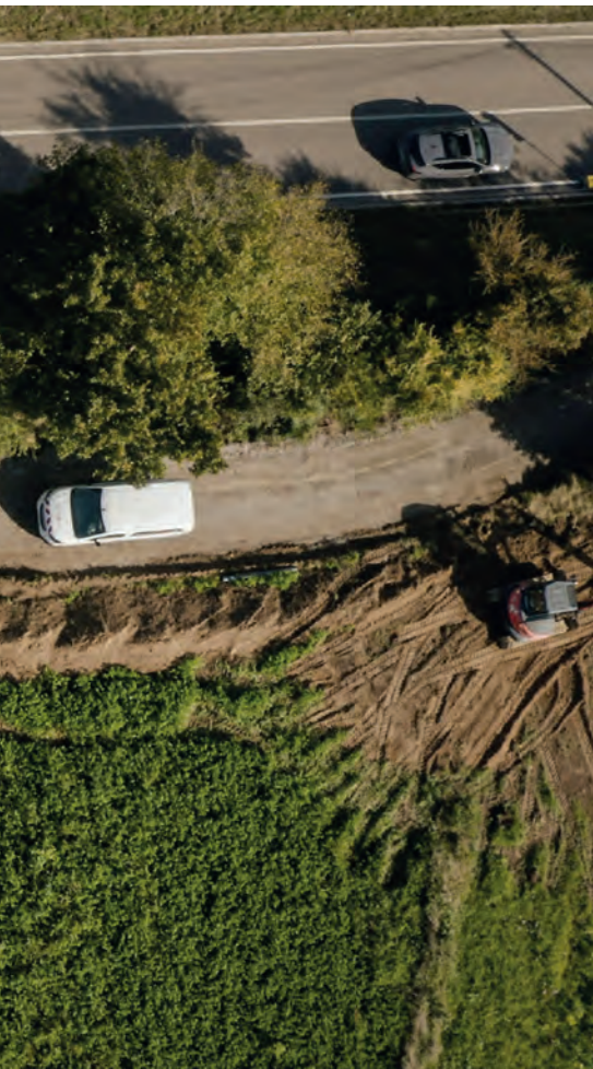
Abb. 3 Startgrube zum Einbringen des Schlauchs
