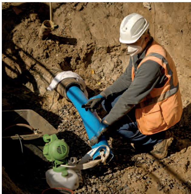
↑ Abb. 4 Einbringen des Schlauchs
